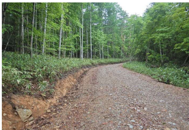
屋根型作業道
