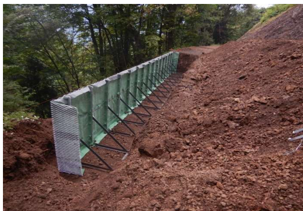
LXウォール施工状況
